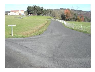
Afin de renforcer la structure de certaines voies communales, principalement celle de La Bastidette, mais aussi sur celle menant au Mazel et sur celle entre Veyrines et Verdun, nous avons fait réaliser des renforcements et du reprofilage de chaussée.
