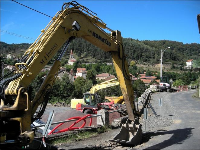
Les travaux permettant la reprise des réseaux d'eau potable, d'eaux usées, et d'eaux pluviales ont commencé en septembre. Nous profitons également des tranchées réalisées pour enfouir les réseaux électriques et téléphoniques présents dans l'emprise des travaux lorsque ceux-ci étaient encore aériens.
