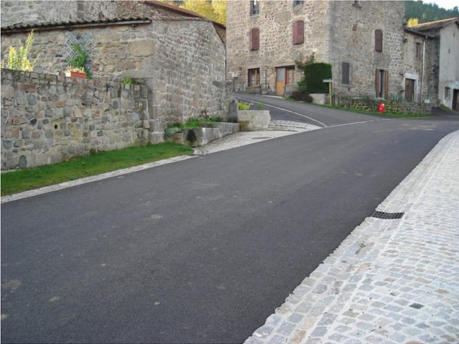
Les travaux au bourg se sont terminés au mois de juin. Ces travaux ont permis la reprise des réseaux d'eau potable, d'eaux usées, et d'eaux pluviales. Ils ont permis également d'enfouir les réseaux électriques et téléphoniques présents dans l'emprise des travaux. L'emprise de la chaussée a été calibrée et les accotements ont été aménagés. Le département de la Haute-Loire a ensuite procédé à la réalisation d'un tapis d'enrobés. Ces travaux communaux ont été subventionnés à 25%.
