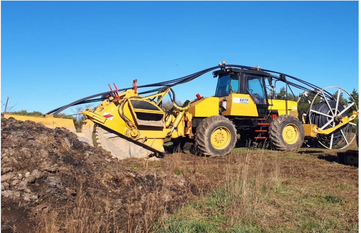
Chantier en cours de la pose à la trancheuse de la fibre optique alimentant Saint-Préjet-d'Allier
